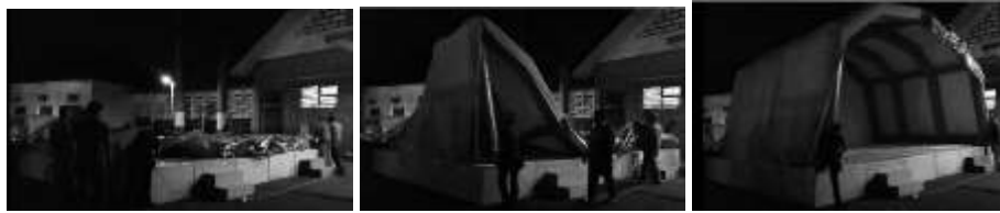
Gambar 6. Pemasangan Atap Panggung Inflatable (6 menit)
