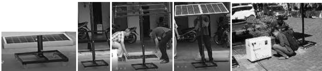
Gambar 7. Pemasangan Portable Bracket dan Panel Solar Energi Fotovoltaik (20 menit)
